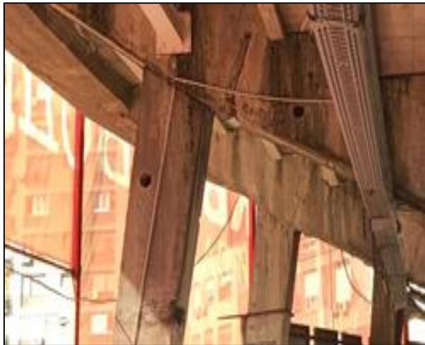
**Figure 17.-**Holes due concrete testing
